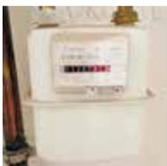
L'index du compteur gaz est fourni en m<sup>3</sup>. Pour obtenir la consommation en kWh, il faut convertir les m<sup>3</sup> de gaz selon l'indice fourni par le fournisseur d'énergie. En règle générale, il est situé entre 10 et 11. Les chiffres en rouge ne sont pas à relever dans le tableau.
